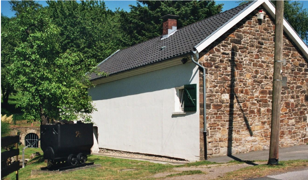
Bet- oder Huthaus der Steinkohlenzeche Vereinigte Pflingstblume mit südlicher Giebel- und verputzter Westwand; hinten lks. der Stollenmund.
