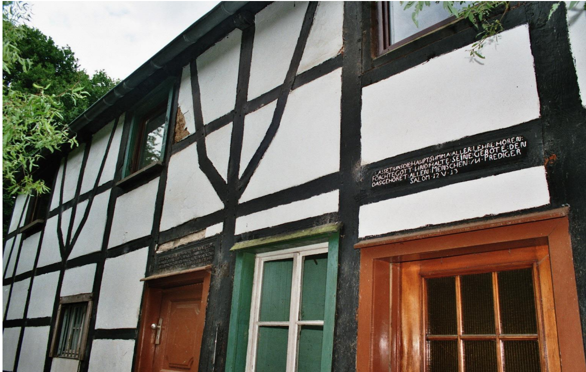
Henkenhof, Fachwerkhaus von 1798, Nordwand mit zwei beschrifteten Balken. Lks. über der Tür Bauinschrift (s.u.), r. Bibelspruch aus dem Alten Testament. 27
